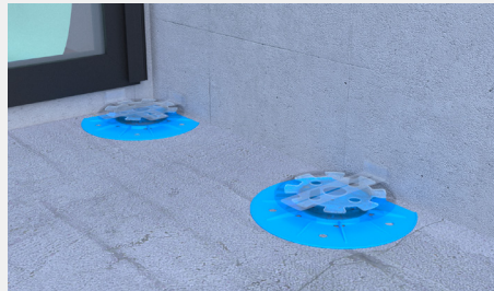
1º Corte de bases en borde y esquina
